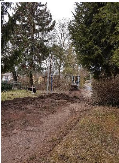
Neue Lampe vor dem Spielplatz am Pumpenhaus
