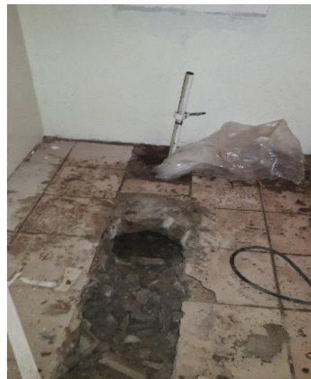
Fotos vom Zustand während der Bauarbeiten
